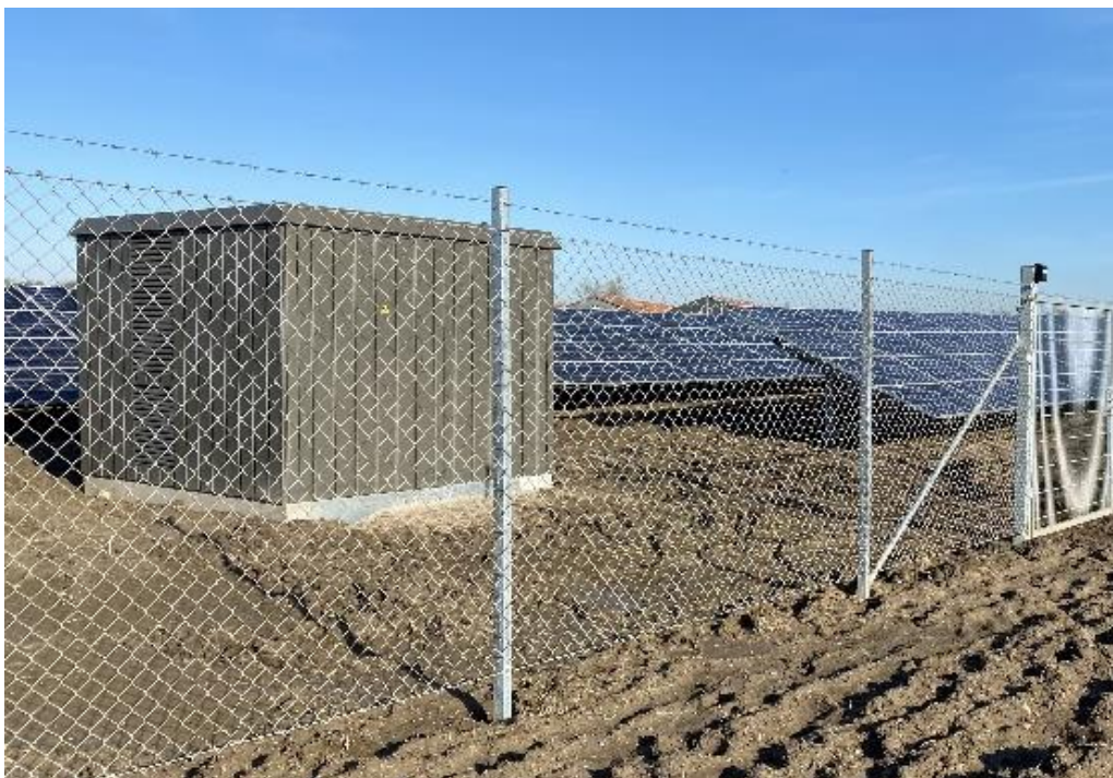
Figur 3-14. Foto eksempel på parktransformer. Kilde: Ecosolar.
