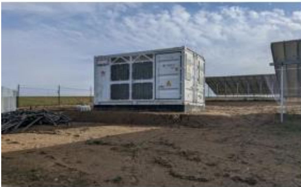
Figur 3-13. Foto eksempel på parktransformer. Kilde: Ecosolar.
